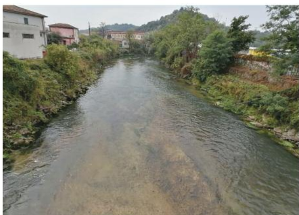
Stazione F1.35 ter - Sora - Via San Domenico Barca
