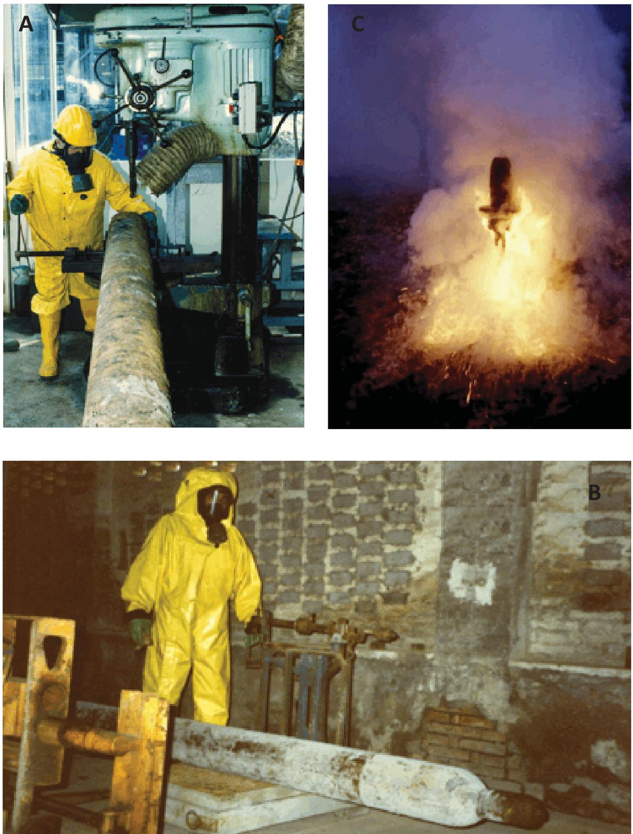
**Figura 25 – Attività di bonifica svolte sul sito nel 1996: A) scaricamento e inertizzazione una bombola tedesca da 300 kg di grossa capacità (4 m x 240 mm) caricata a fosgene (95 kg di aggressivo); B) pesatura preventiva della stessa bombola condizionata a - 20°C; C) inertizzazione del materiale incendiario (fosforo) di una bomba da mortaio da 81 mm**
