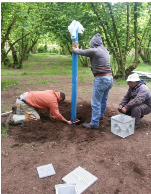
**Figure 5 – Fasi di completamento del piezometro PzE**
