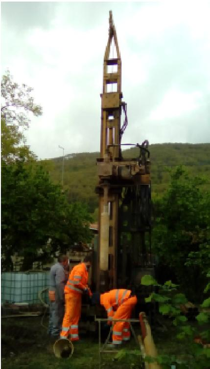
**Figure 6 - Approntamento piezometro PzN**
