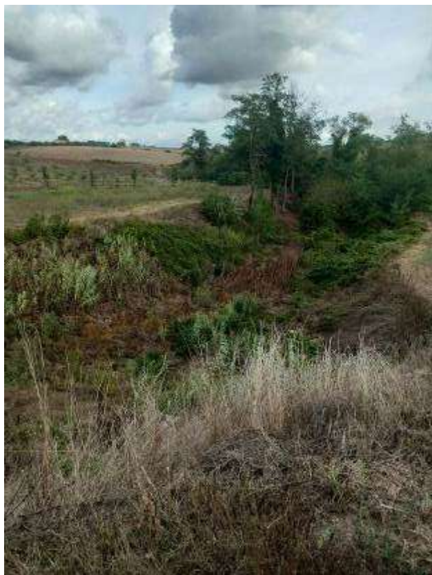
Figura 60: Fosso Rio Tre Denari all'altezza di Via del Casale di Sant'Angelo.
