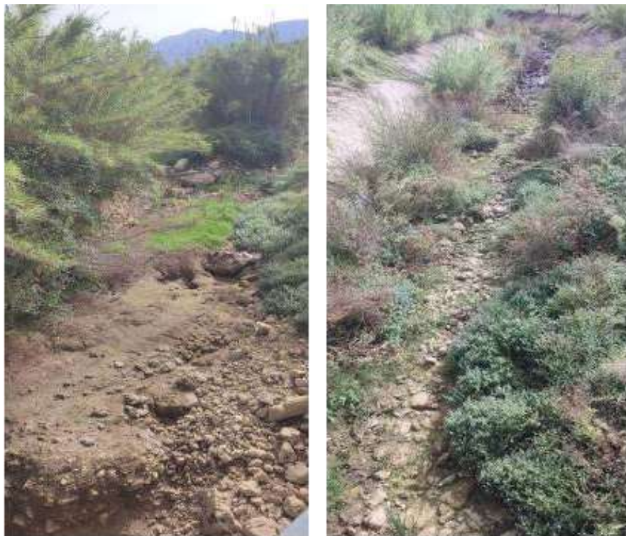
Figura 77: diverse foto del punto di sopralluogo sul C.I.
