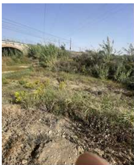
Figura 35: particolare alveo Torrente Tafone 2 – Ottobre 2024
