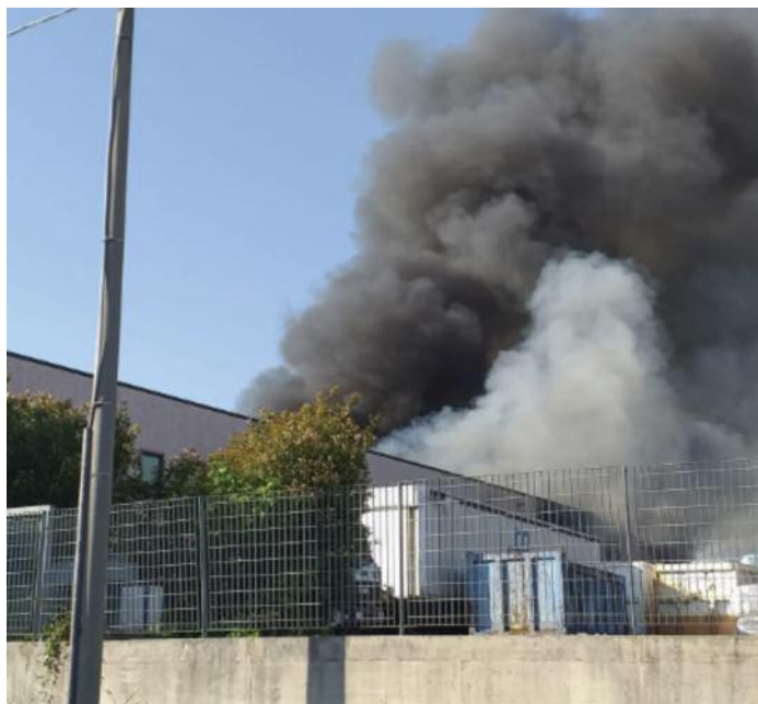
Figura 34: Incendio all'azienda M.ECO.RI.S. del 23.06.2019 (Foto da sito https://www.ciociariaoggi.it/ ).
