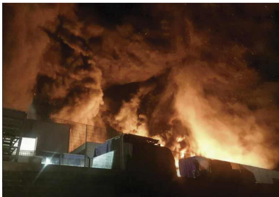
Figura 19: Incendio al capannone della "Pomezia Pneumatici" del 04.03.2018 (Foto da sito www.ilcorrieredellacittà.com )
