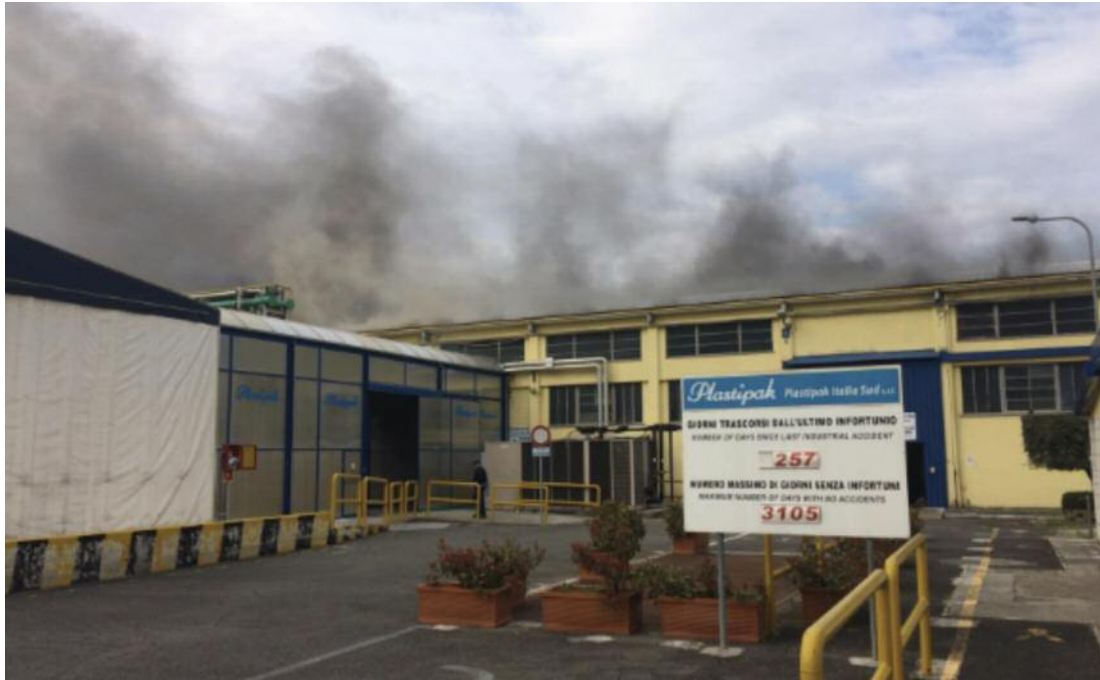
Figura 32: Incendio alla fabbrica “PlastipaK Sud” del 20.03.2019 (Foto da sito https://www.ciociariaoggi.it/ ).
