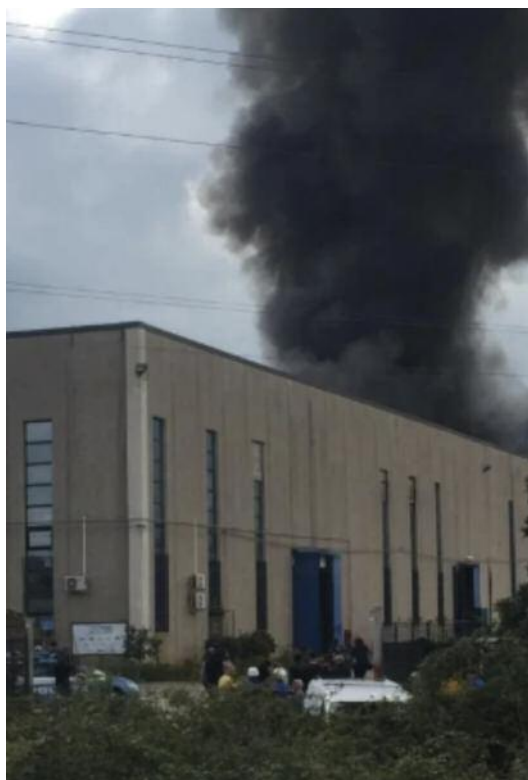
Figura 43: Incendio al capannone industriale di pellame nella zona ASI di Frosinone del 02.11.2019 (Foto da sito https://www.ilmessaggero.it/ ).
