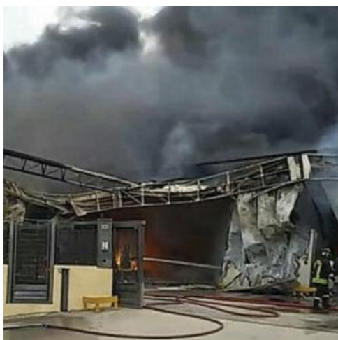
Figura 20: Incendio al capannone della “GB Trade” del 30.03.2018 (Foto da sito https://roma.repubblica.it/ )
