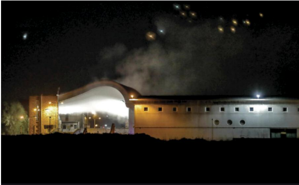
Figura 33: Incendio al TMB di Rocca Cencia del 24.03.2019 (Foto da sito https://www.iltempo.it/ ).
