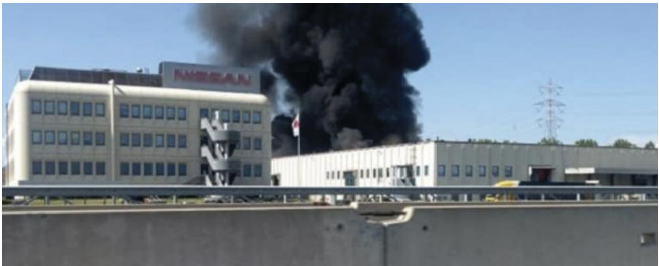
Figura 25: Incendio al capannone “Nissan” di Capena del 14.09.2018 (Foto da sito http://www.romatoday.it/ ).
