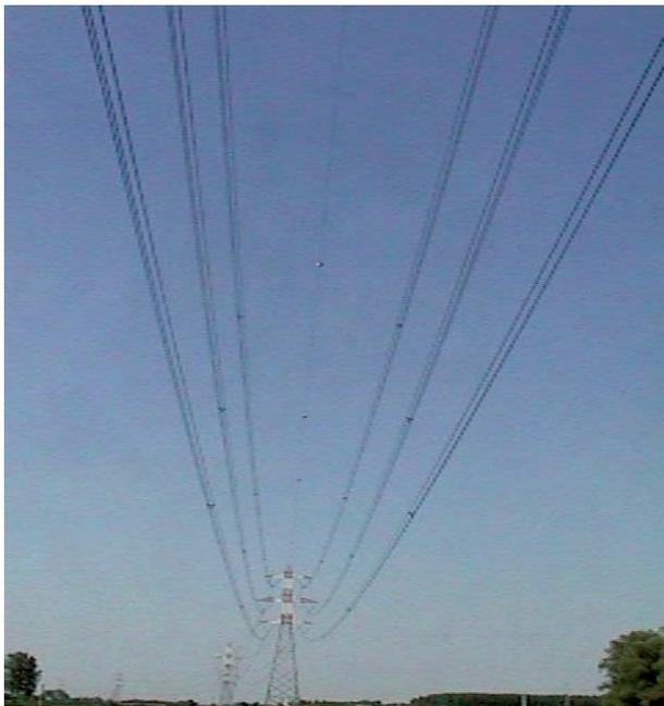
La distribuzione dell'energia elettrica avviene generalmente con linee alimentate a 132 kV e 60 kV (linee ad alta tensione o AT), e successivamente a 15 kV (linee a media tensione o MT) e a 380 o 220 V (linee a bassa tensione o BT). Sul territorio sono frequenti le stazioni di trasformazione per l'abbassamento della tensione da 132 kV a 15 kV e a 380 V.
