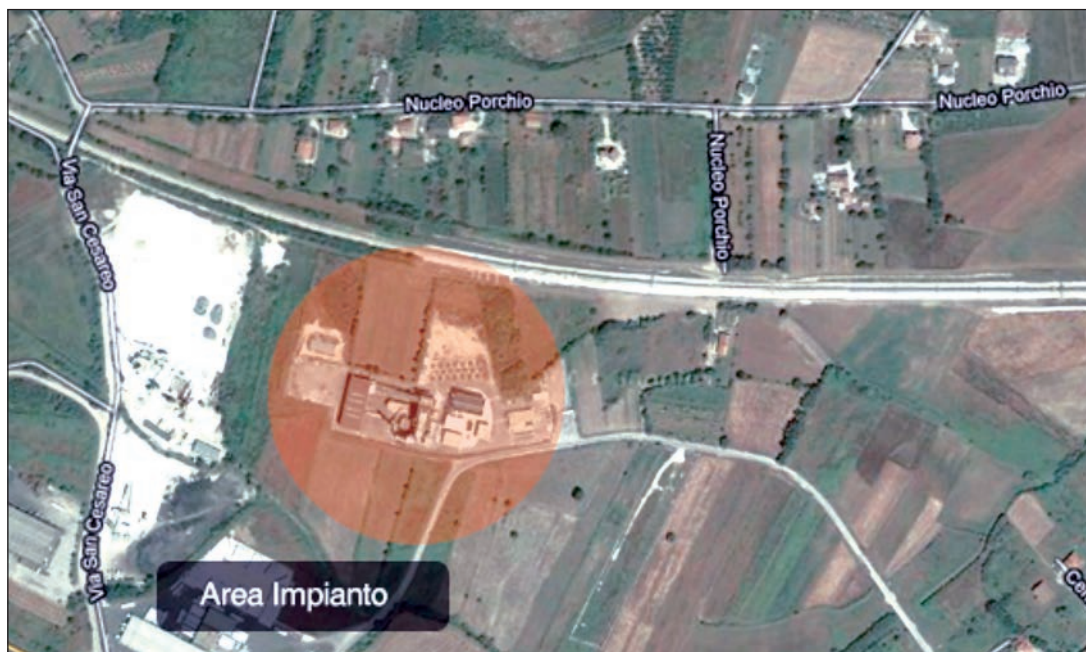
Fig. 3.2 - Fotografia aerea dell'impianto di termovalorizzazione
