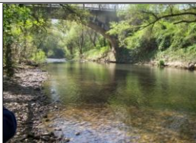
Stazione F1.73 – Ceprano “Via Casilina”
