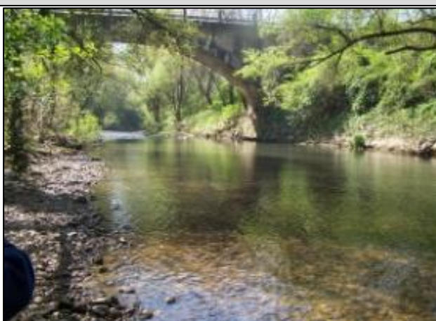
Stazione F1.73 – Ceprano “Via Casilina”
