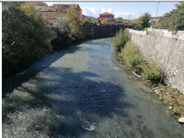
Stazione F1.35 quater – Isola del Liri “Via Po”
