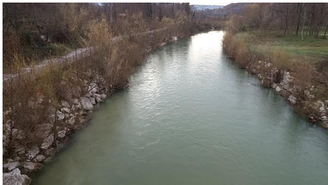
Stazione F1.35 – Sora “Le Compre”
