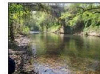
Stazione F1.73 - Ceprano "Via Casilina"
