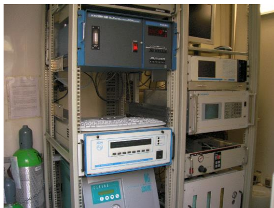
Fig. 11.79: interno tipico di una Centralina di Monitoraggio (ARPA Lazio)
